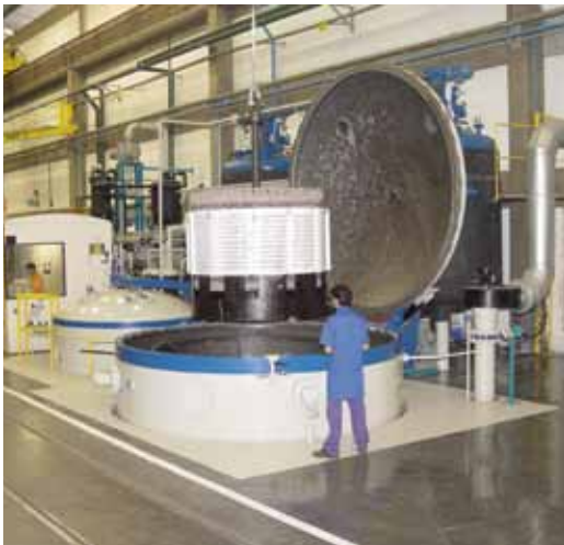
Impregnación al vacío - VPI
